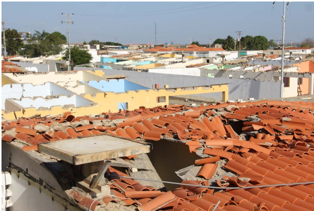
Foto d.5.4: Destrucción de viviendas en sector San Rafael.
