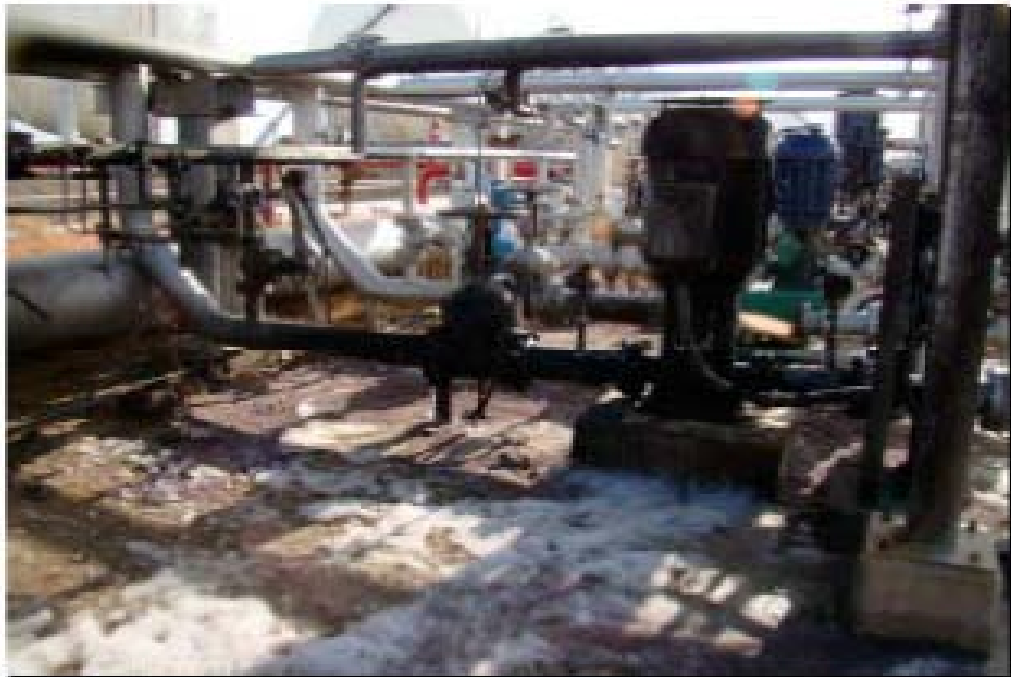
Fotoj.1:Incendio registrado en bomba P-200 el 30/06/12
