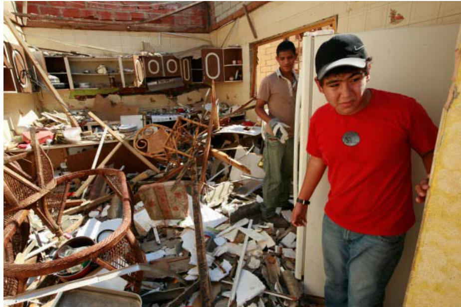
Foto d.5.1: Destrucción de viviendas en sector El Campito.
