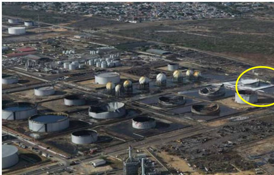
Foto d.4.1: Uso localizado e ineficiente de la espuma
