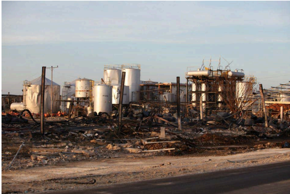
Foto d.5.12: Vista daños área producción y almacenaje de la Planta de PURAMIN. Fecha: 29-08-12
