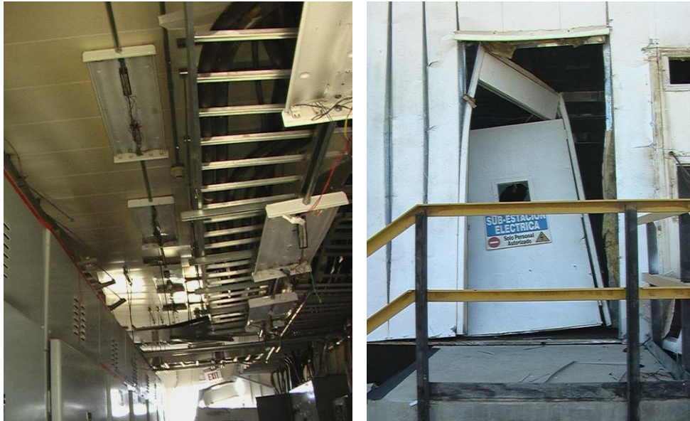
Foto d.5.17: Vistade daños en la subestación eléctrica de CHP.Fecha:25-08-2012.
