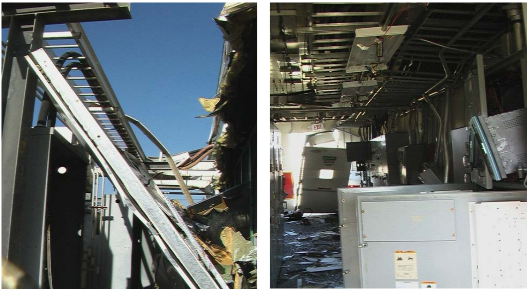
Foto d.5.16: Vista daños Instalaciones(CHP). Fecha:25-08-2012
