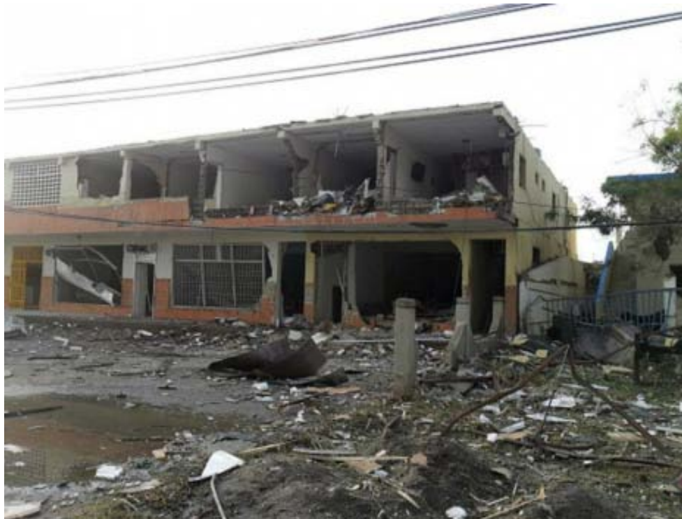
Foto d.5.9: Vista de los daños en el área comercial del sector La Pastora.
