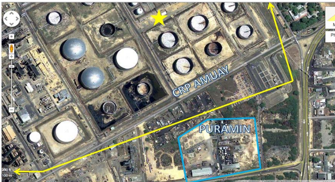
Foto d.5.11: Vista de la ubicación planta PURAMIN frente a Bloques 23 y 24 de la Refinería Amuay
