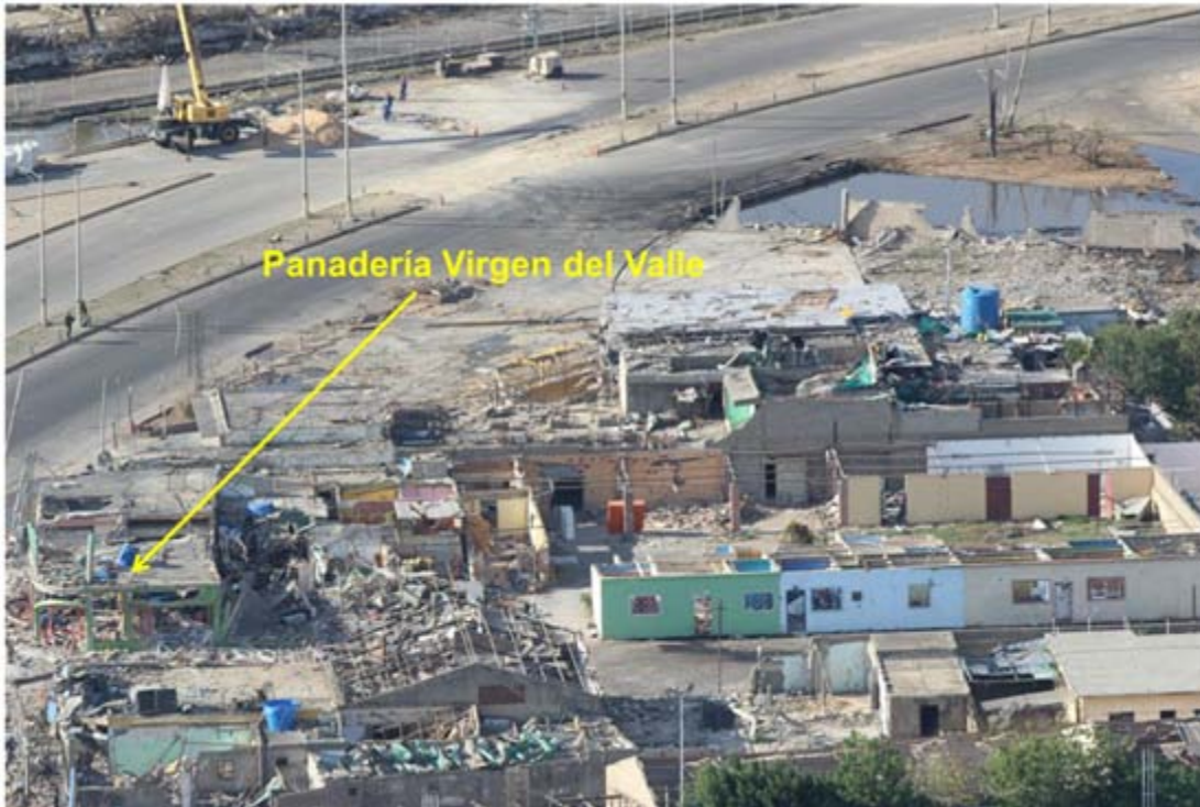
Foto d.5.10: Vista de los daños en el área comercial del sector La Pastora.
