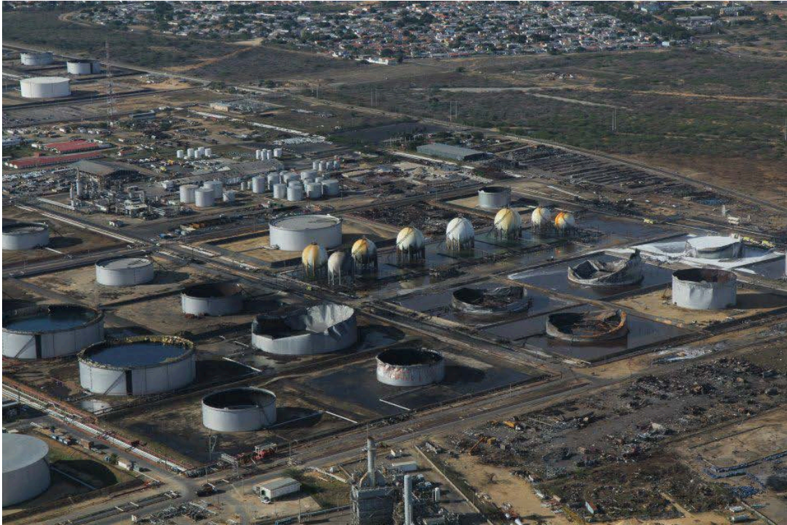
Foto d.1.1: Zona afectada por el incendio en Bloques 23 y 24 Refinería Amuay
