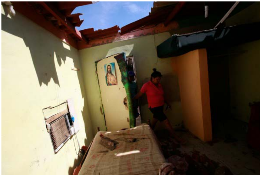
Foto d.5.2: Destrucción de viviendas en sector El Campito.
