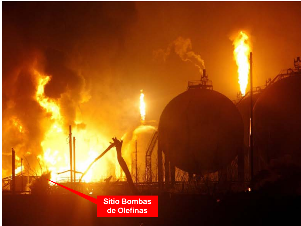
Foto j.2: toma fotográfica foco del incendio 25/08/12 en área bomba P-200
