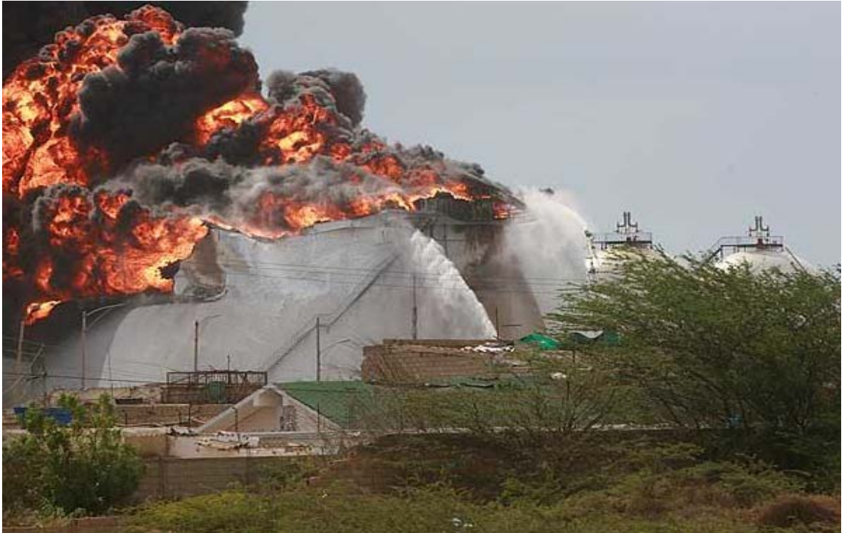
Fotografía i.3: Aplicación simultánea de agua y espuma redujo efectividad de la espuma para sofocar el incendio
